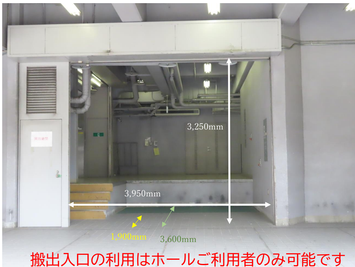
青少年文化センター 搬出入口シャッター奥部分
