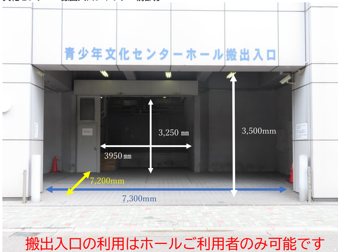
青少年文化センター 搬出入口シャッター前部分
